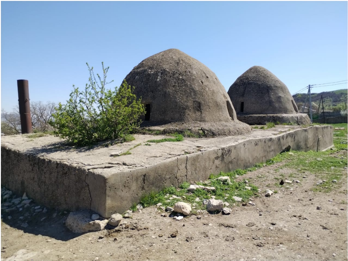
Xızı rayonu Xızı şəhərində yerləşən 19cu əsrə aid olan Gümbəzli hamam. Hamam Şərq memarlığı üslubunda tikilib, isti olması üçün yerdən cəpma və tağlı formada inşa edilib. Hamamı qızdırmaq üçün əvvəllər odun, kömür, sonralar isə mazutdan istifadə edilib.
