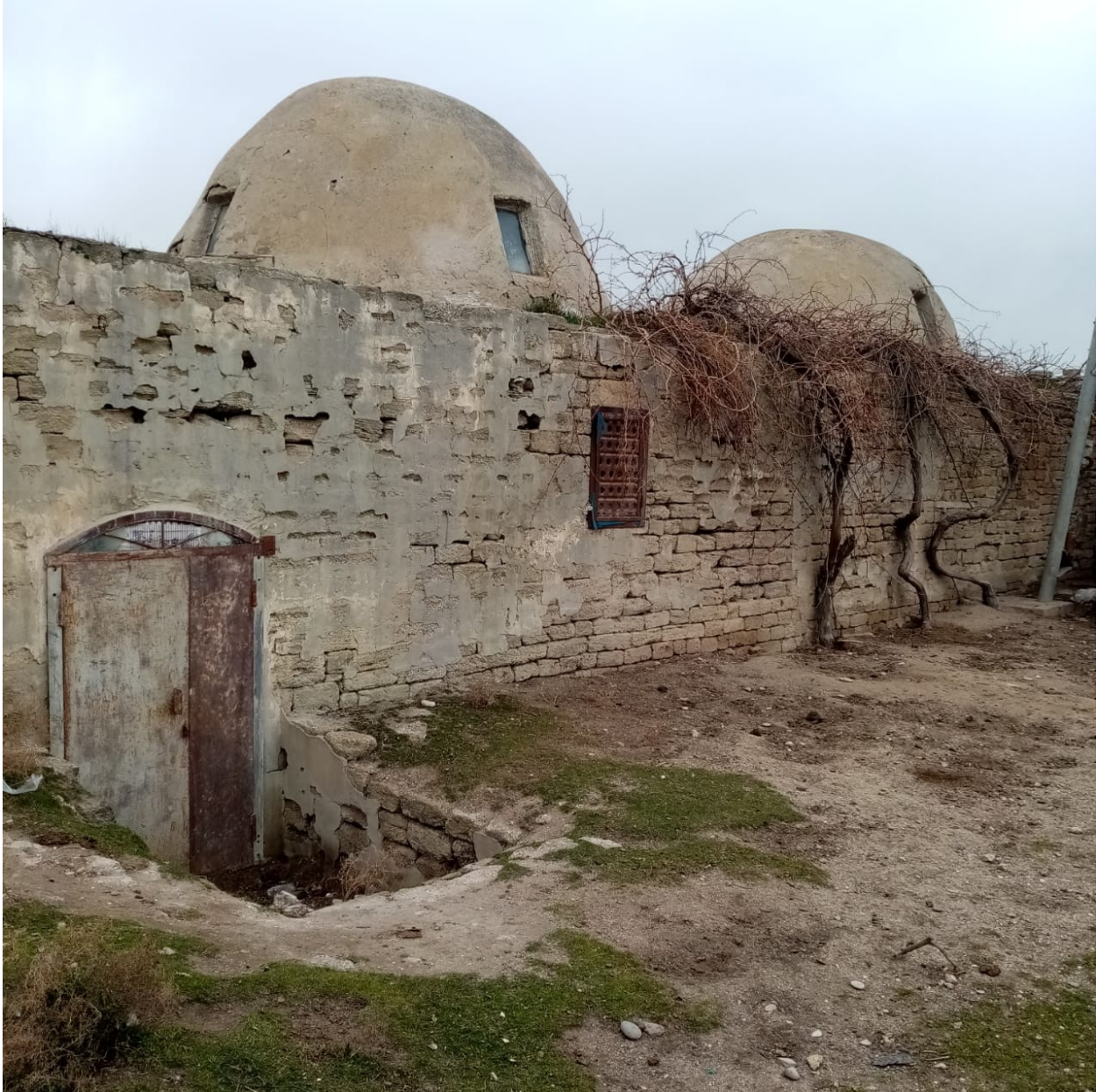
Xızı rayonu Şorabad qəsəbəsindən yerləşən, 19 cu əsrə aid olan Gümbezli hamam. Tikili Şərqi memarlığı üslubunda, yeri cildaş və əhəng məhlulundan istifadə olunmaqla inşa edilmişdir. Tikili sovet dönəmində sement məhlulu ilə suvanmışdır. Hal hazırda tikilinin vəziyyəti qənaətbəxşdir.
